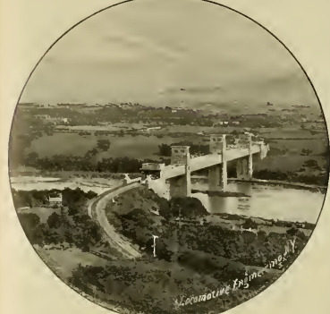
BRITANNIA TUBULAR BRIDGE
